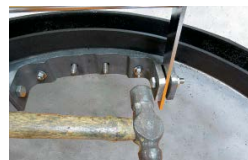
④ハンマーで芯棒を打ち込んでください。スリッパ部が開き、下穴の壁面に食い込み固定されます。
