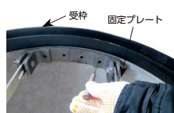
①マンホール内壁に固定プレートを当てアンカー位置をケガイてください。
