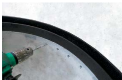
②ケガキに合わせてドリルで下穴を開けてください。下穴径8.5mm 深さ45mm 穴加工後内部の削り屑を取り除いてください。
